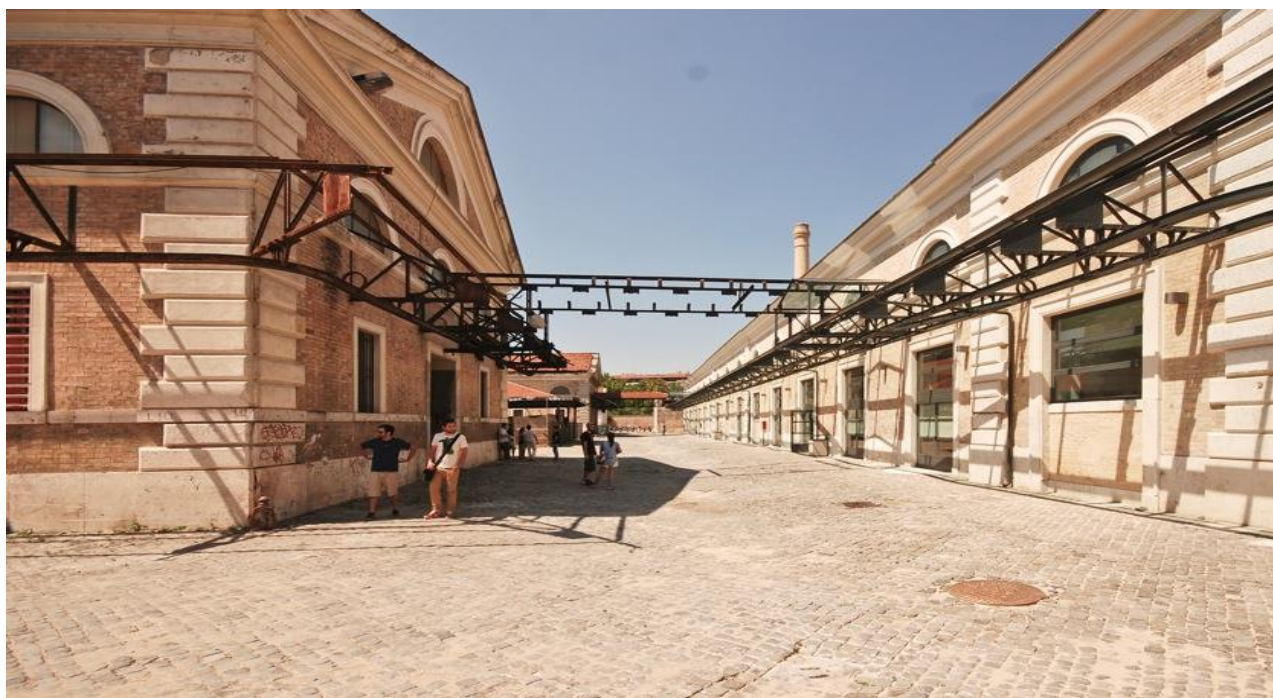
Dipartimento di Architettura, ex Mattatoio di Testaccio
